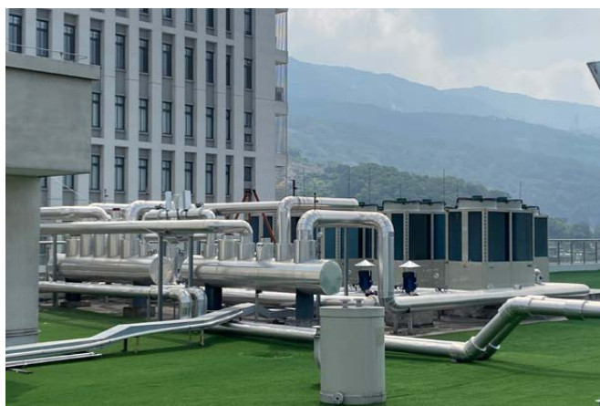
▶ 新增氢氟酸过滤塔，处理实验中的氢氟酸挥发气体，并最终通过过筛酸碱反应达标后排放
