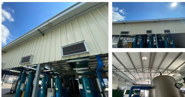
改造后的屋顶储气罐区
